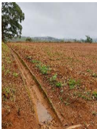
FOTO 1: Mina Campo das Águas Espriadas: canaletas circundando o Pátio de Blendagem
