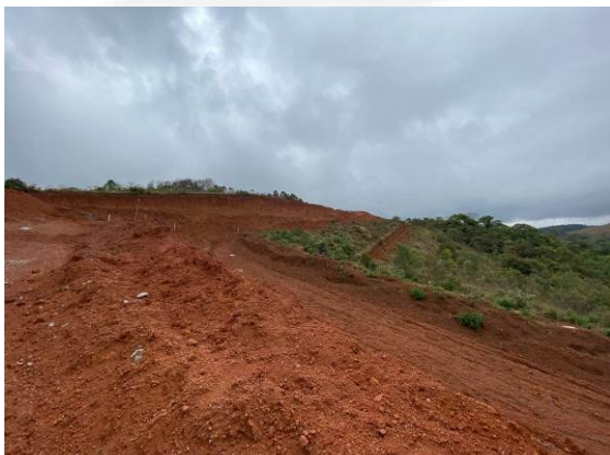
FOTO 9: Mina Morro das Árvores VI: área de lavra.
