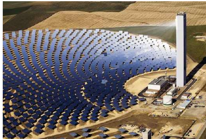
Sistema de Torre de Concentração solar
