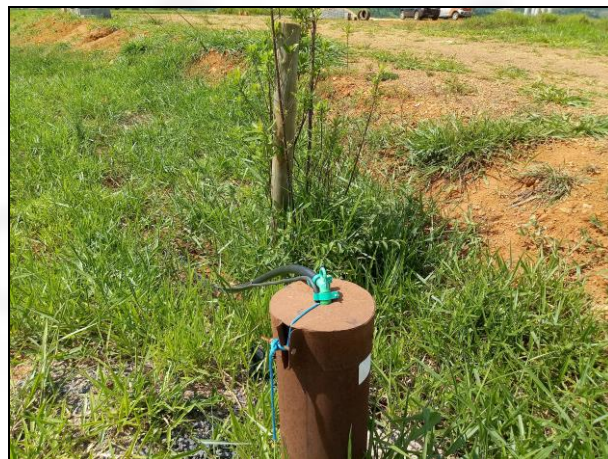
Figura 2: Captação de água subterrânea.
