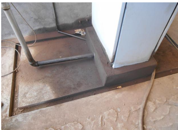
Foto 01: Bomba de combustíveis
