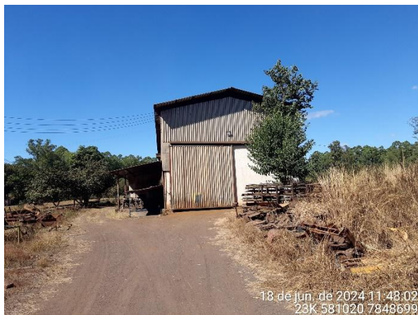
Foto 43: Galpão da oficina todo fechado.
