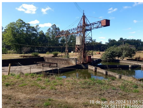
Foto 68: Estrutura que recebe a lama do lavador para ser decantada, e posteriormente separado líquido dos sólidos
