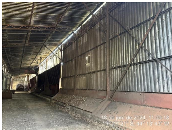
Foto 8: Galpão de carvão
