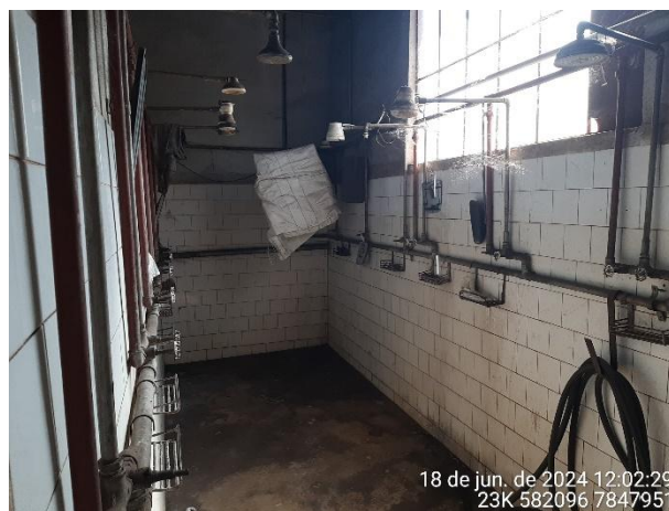
Foto 46: Banheiro com área de chuveiros.
