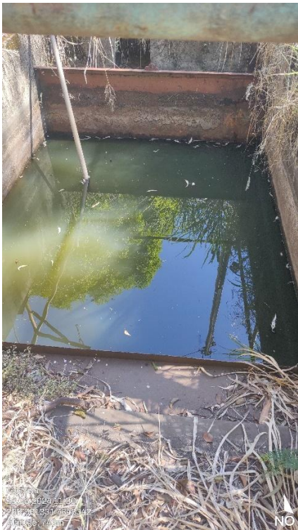
Foto 77: Bacia de decantação que recebe todo o efluente pluvial do empreendimento
