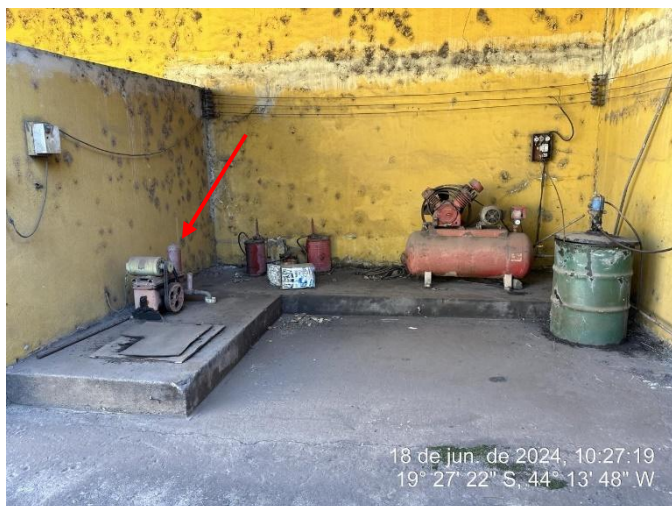
Foto 37: Área do compressor e área a qual se localiza a bomba de água que subsidia o sistema de lavador de veículos (indicada por seta).
