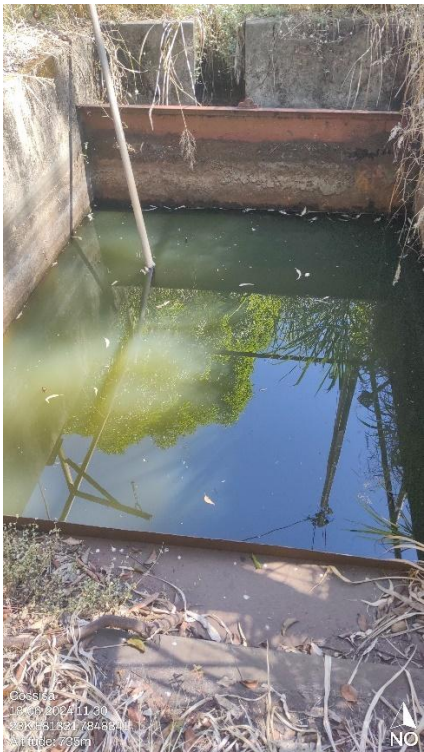
Foto 78: Bacia de decantação que recebe todo o efluente pluvial do empreendimento
