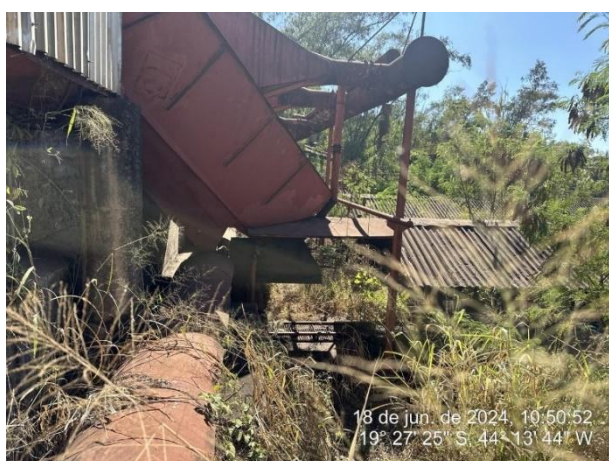
Foto 11: Parte do sistema de exaustão de descarregamento de carvão
