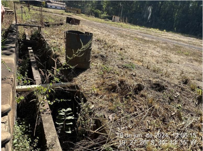
Foto 80: Canaletas do sistema de drenagem com divisão central
