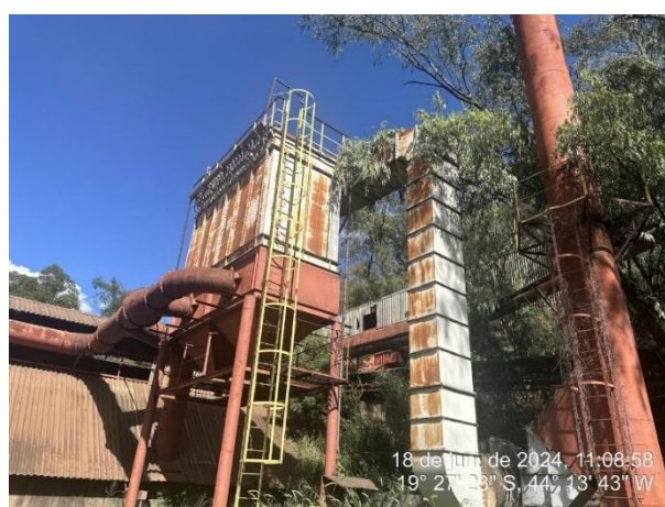
Foto 12: Filtro de mangas que contempla sistema de descarga de carvão e também do sistema de peneiramento do carvão do alto-forno 03
