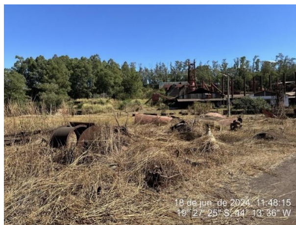
Foto 62: Sucata metálica disposta diretamente no solo
