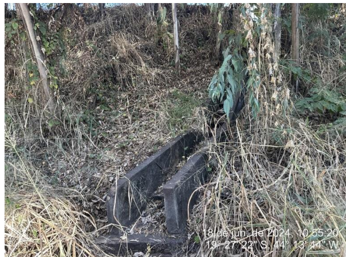
Foto 74: Redutor de velocidade de água pluvial, que contempla o sistema de drenagem do empreendimento
