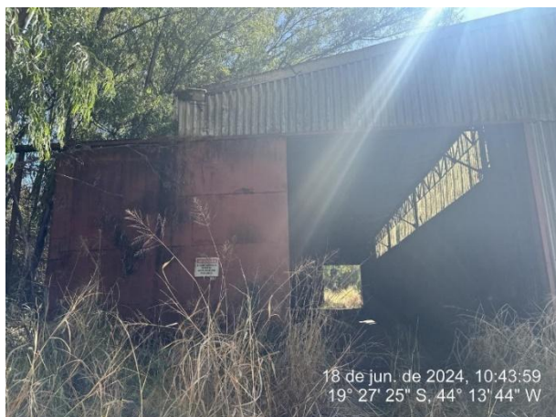
Foto 7: Galpão de carvão
