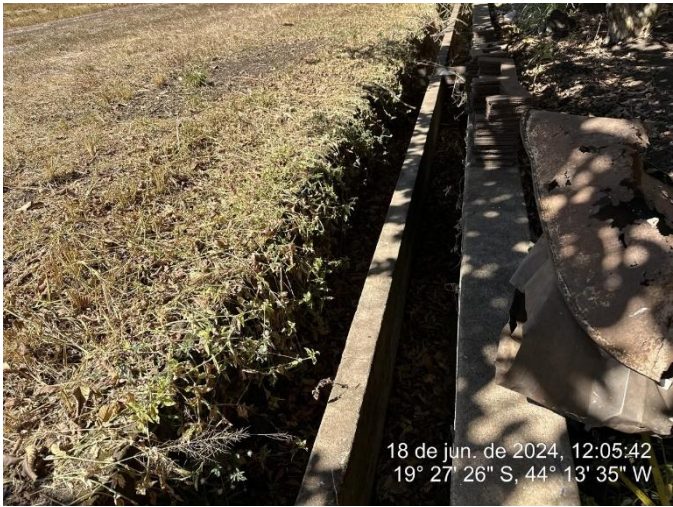
Foto 79: Canaletas do sistema de drenagem com divisão central
