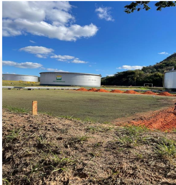
Foto 02. Área destinada à implantação da torre de resfriamento.
