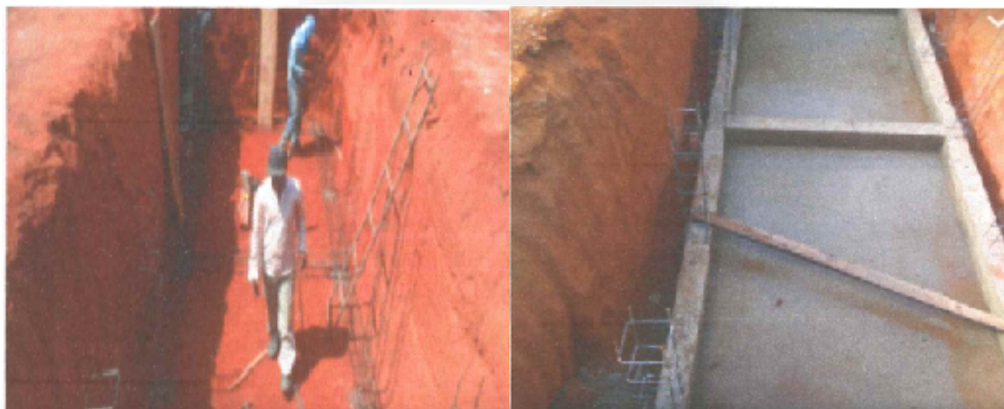
Figura 1: Andamento das obras das fossas sépticas.
