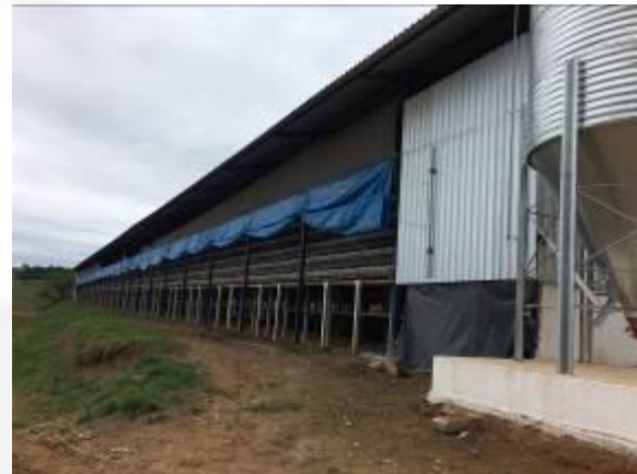
Foto 04 - Galpão em operação.
