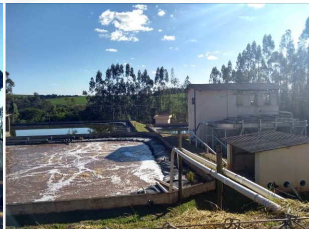
Foto 04. Vista parcial da ETE
