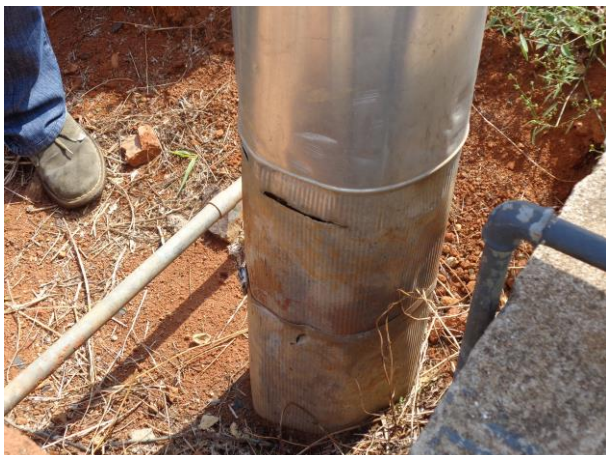
Figura 06. Danos na tubulação (área de óleo e diesel).
