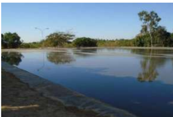
Foto 06. Lago anaeróbica
