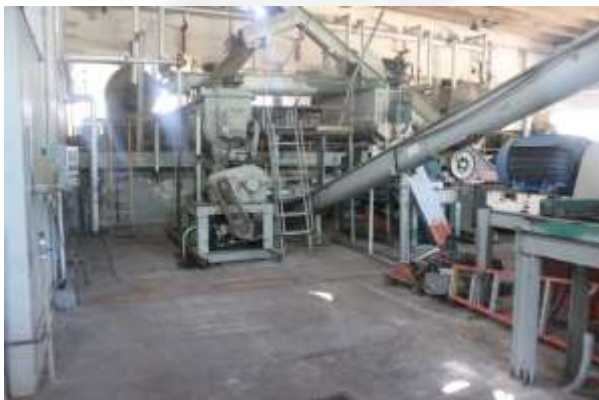
Foto 01. Área interna da graxaria
