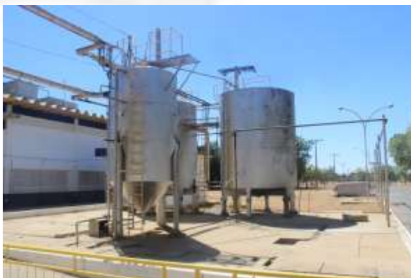
Foto 08. Silos de armazenamento de sebo
