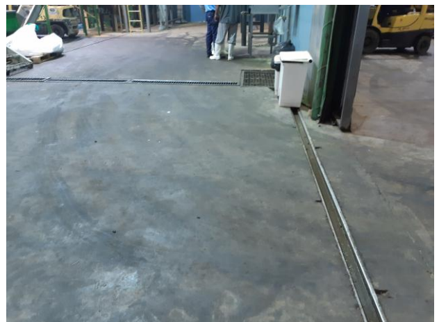
Figura 04. Canaletas de drenagem na área de produção
