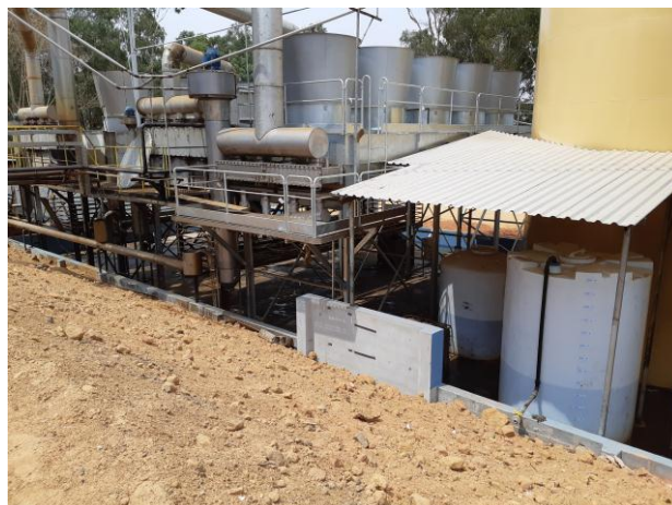
Figura 06. Aerocondensadores
