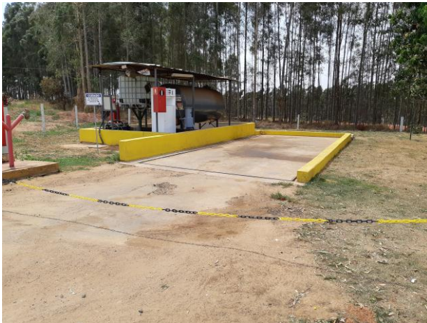
Figura 01. Área de abastecimento de veículos
