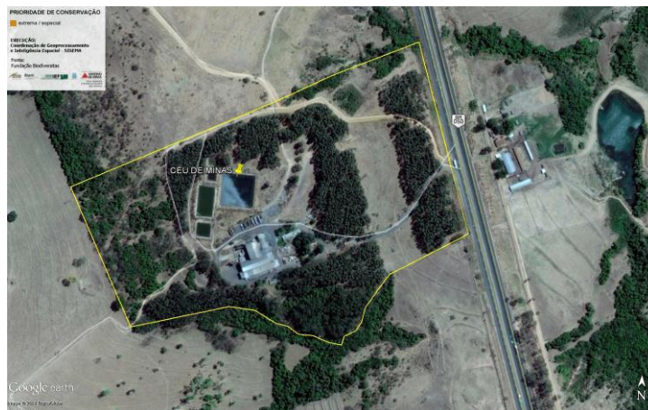
Figura 01. Vista aérea do empreendimento Fonte: Google Earth (08/08/2018)
