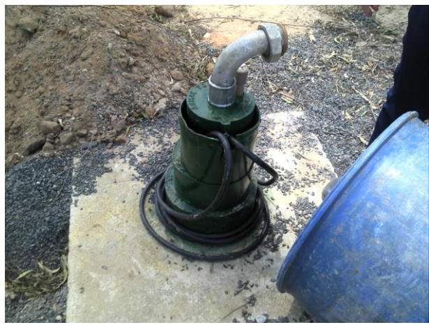
Figura 08. Poço tubular
