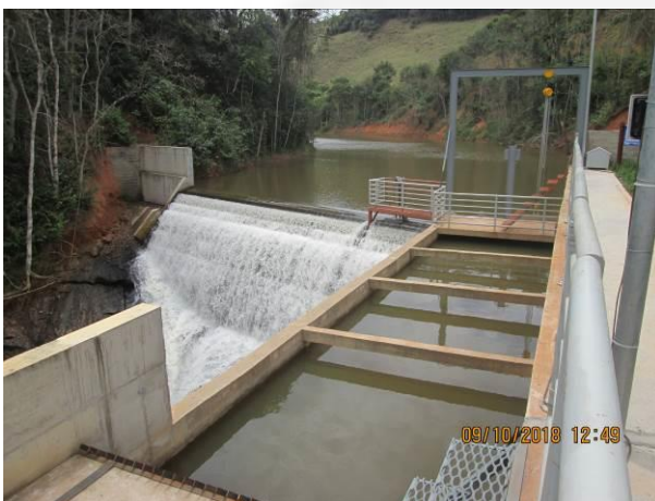
Figura 01: Barramento e tomada d'água
