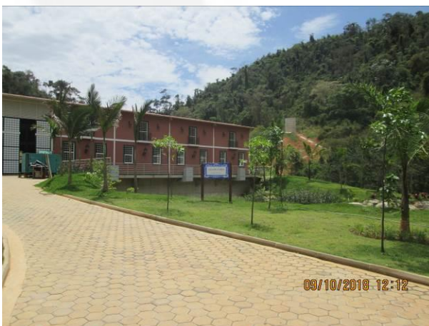
Figura 03: Casa de força
