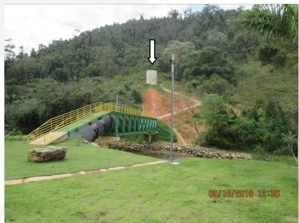
Figura 02: Chaminé de equilíbrio ao fundo e travessia do conduto
