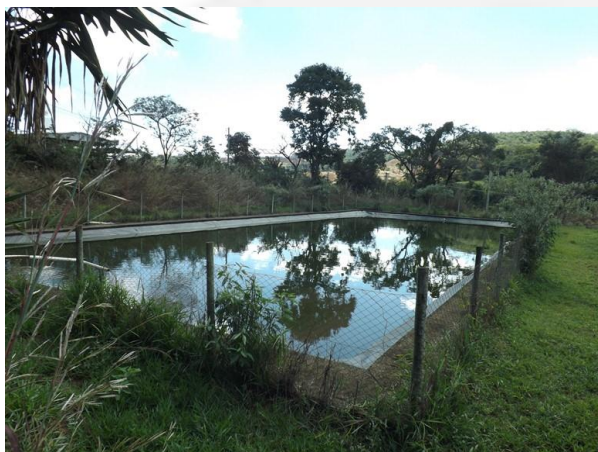
Foto 01. Lagoa de Estabilização do Efluente Sanitário
