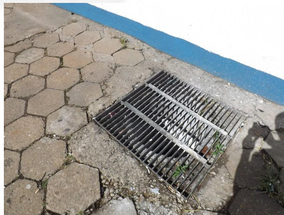
Foto 02. Parte do Sistema de Drenagem Pluvial
