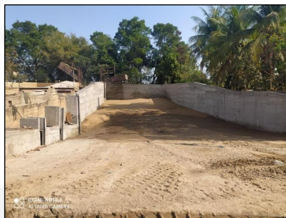
Foto 6: Sistema de retenção de sólidos em funcionamento (Fonte: PA).
