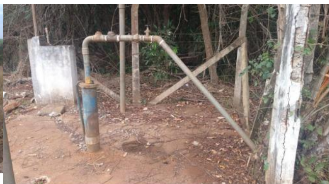
Foto 12. Medidor Calha Parshal do efluente tratado final.
