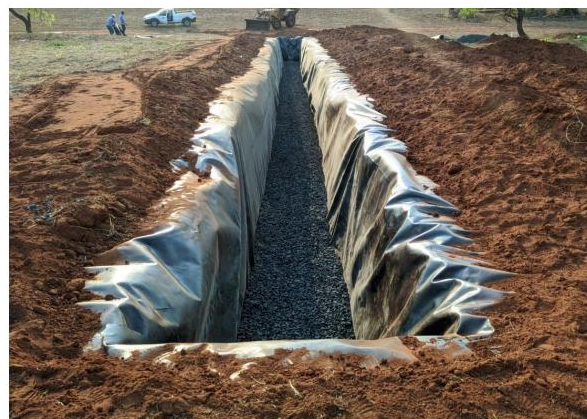
Imagem 05: Vala sanitária com sistema de drenagem instalado.
