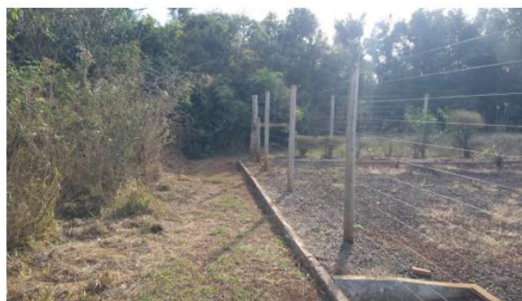
Foto 03. Cercamento da área da ETE.
