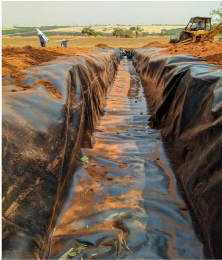
Imagem 01: Impermeabilização da vala com manta pead 2mm.
