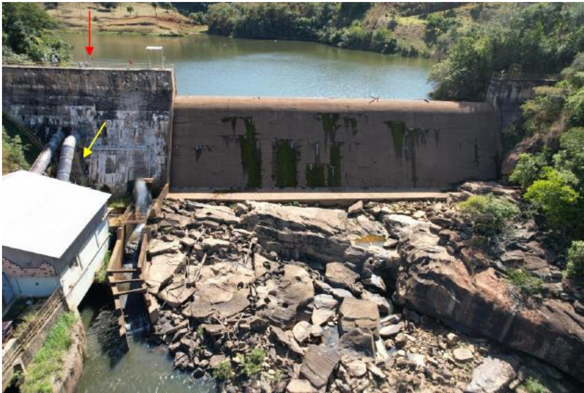
Figura 5: Vista aérea da tomada d'água (seta vermelha) e dos condutos forçados (seta amarela). Fonte: RADA, 2024 (pág. 14).
