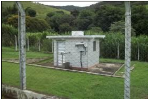
Foto 01. Local do Poço Tubular (Fonte).
