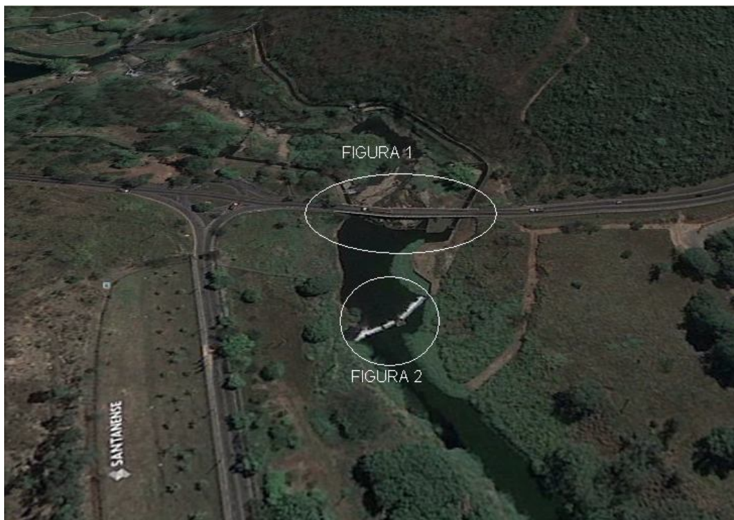
Figura 2: Área requerida atualmente. Destaque para a ponte já existente (Fig. 1) e barragem da Santanense (Fig. 2).
