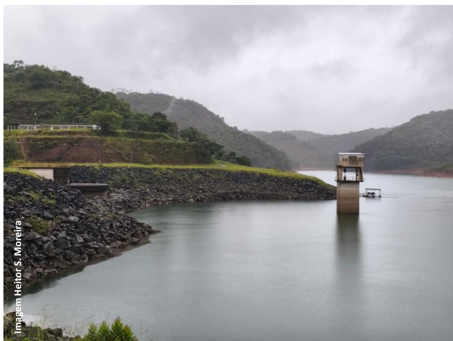
Barragem Chapéu D'Úvas – Ewbank da Câmara - MG.
