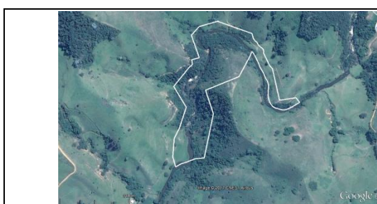
Figura 1. Limite da propriedade do empreendimento CGH Areão. Imagem de 2016, satélite Google Earth do local, antes da instalação.
