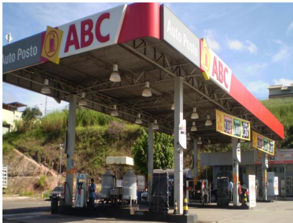
Foto 01. Vista geral do posto
