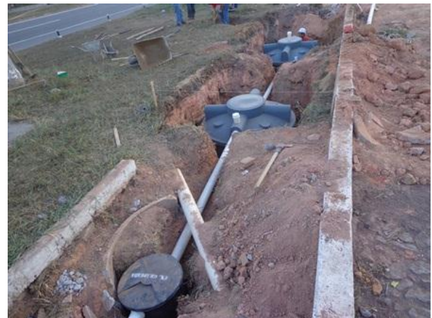
Foto 02. Instalação da ETE
