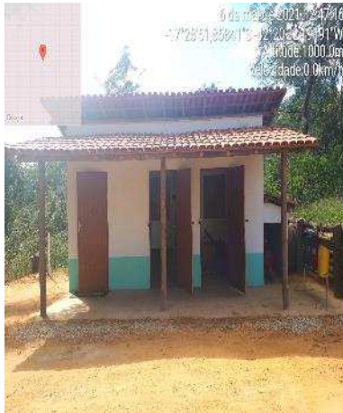
Figura 7. Almoxarifado com banheiro
