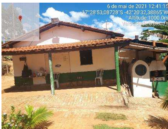
Figura 5. Casa do caseiro
