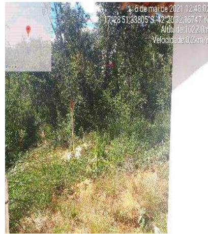
Figura 8. Biodigestor do almoxarifado
