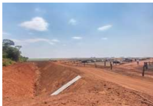
Foto 02. Lagoa de estabilização em construção
