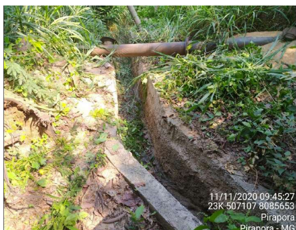
Figura 11: Canaleta de retorno de água para o rio.
