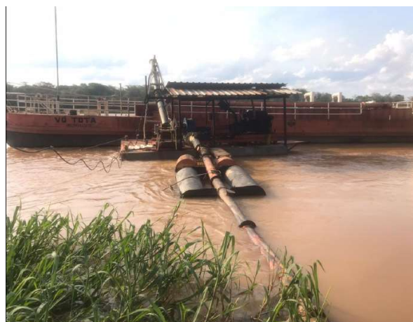
Figura 08: Dragagem e tubulação de transporte de polpa.
