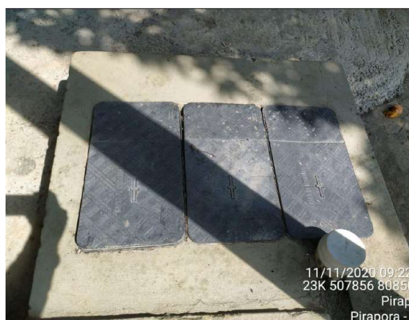
Figura 06: Caixa Separadora de Água e Óleo – CSAO.
