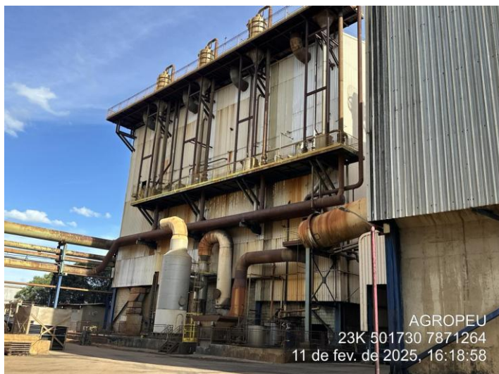
Foto 19: Parte da estrutura que contempla usina de produção de açúcar.
