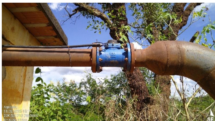
Foto 37: Hidrômetro associado à captação hídrica.
