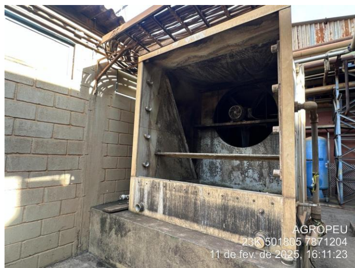
Foto 34: Vista da parte interna do exaustor da caldeiraria.
