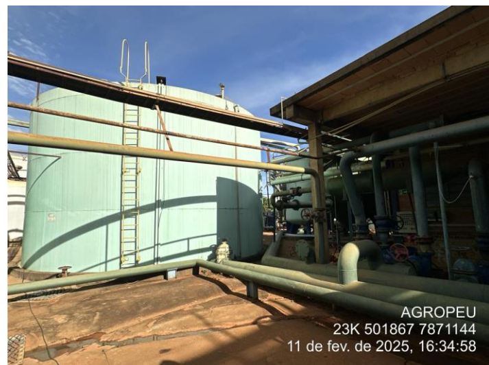
Foto 40: Reservatório de água após etapa de clarificação.
