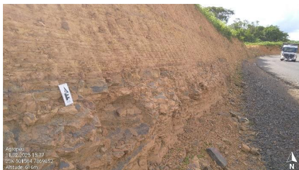
Foto 99: Corte em talude expondo litotipo da Formação Serra de Santa Helena: siltitos plano paralelos
