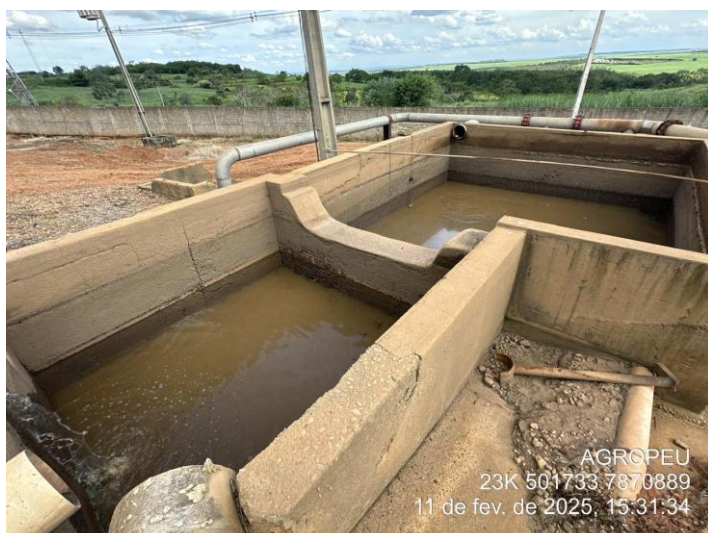
Foto 63: Local onde o efluente da CSAO é direcionado pós separação e bombeado para o tanque de vinhaça.
