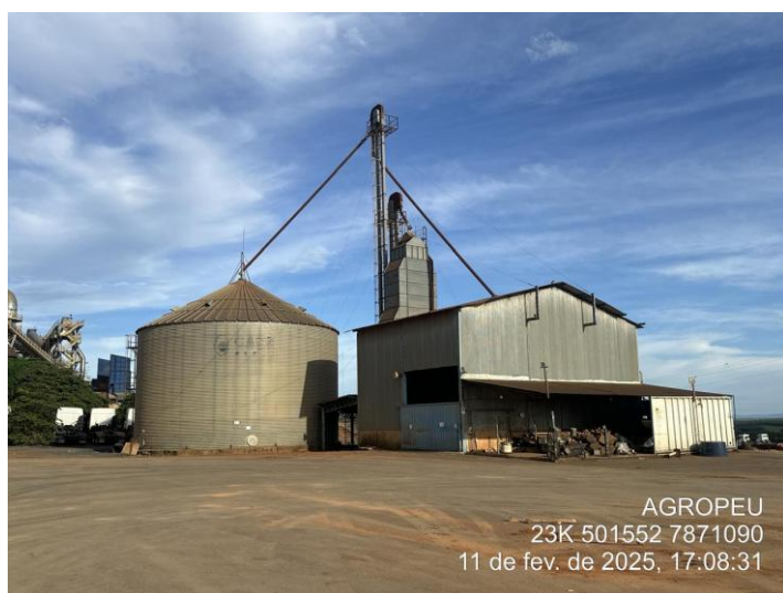
Foto 1: Silo para armazenamento de grãos. Atualmente inutilizado.
