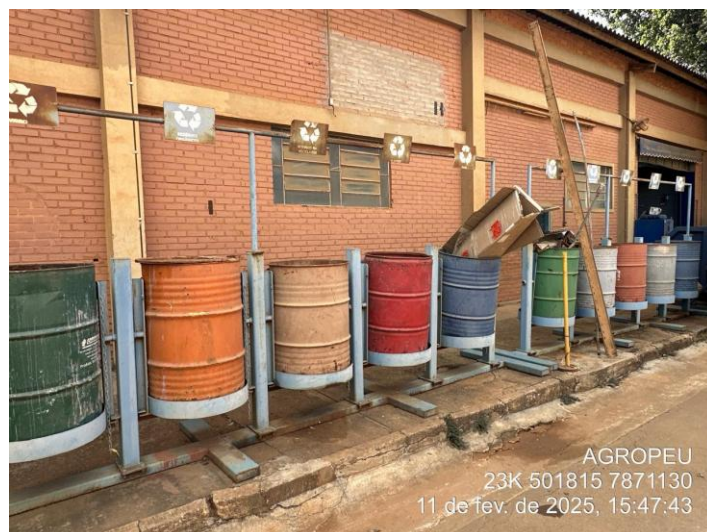
Foto 48: Tambores metálicos que armazenam os resíduos classe II.
