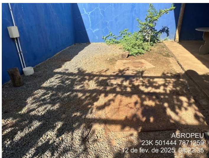
Foto 59: Fossa associada à área de recreação/refeitório.
