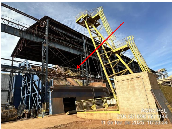
Foto 5: Seta vermelha indicando as esteiras onde os talhões de cana são despejados para início do processo. Possível observar que a estrutura estava em manutenção.
