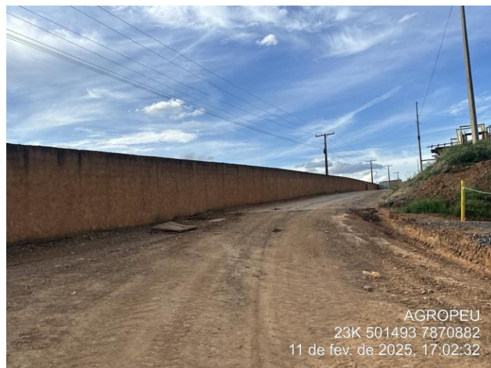
Foto 28: Possível observar que a linha de distribuição segue pela área externa do empreendimento.
