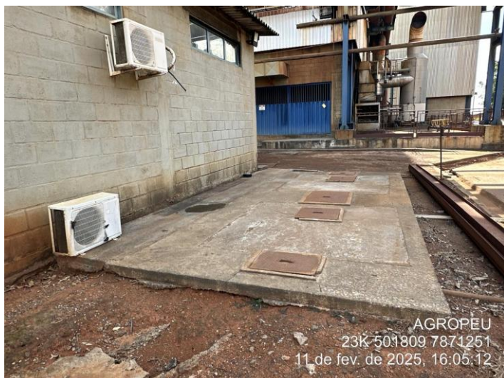
Foto 57: Fossa associada ao prédio "COI".
