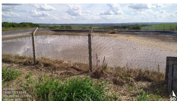
Foto 101: Tanque de decantação.
