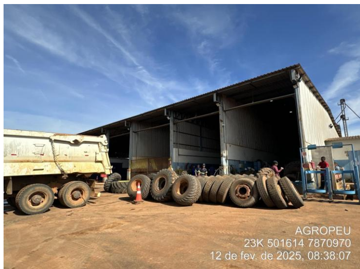
Foto 65: Vista do galpão da oficina mecânica.
