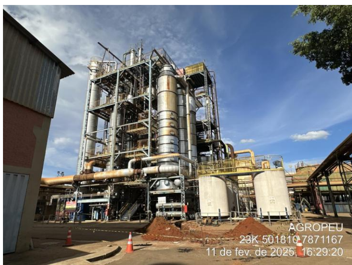
Foto 17: Intervenção que estava ocorrendo no momento da vistoria, em frente ao prédio da destilaria.
