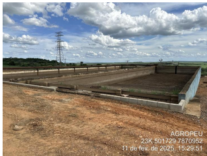
Foto 78: Tanques de decantação.
