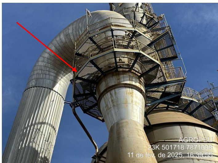
Foto 29: Local indicado ser o lavador de gases da caldeiraria.
