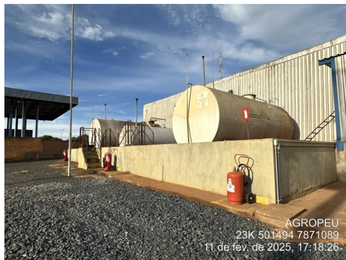
Foto 70: Área dos tanques de combustíveis do posto.
