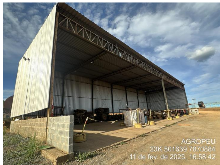
Foto 42: Vista do galpão de resíduos.
