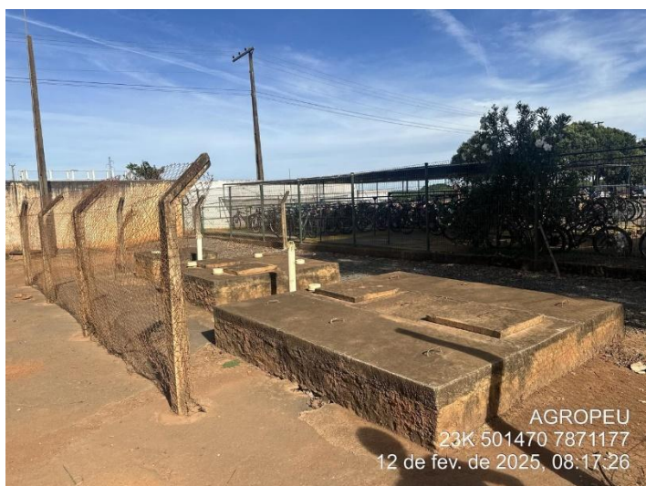
Foto 55: Fossa associada à portaria.
