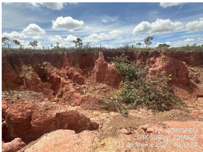
Foto 85: Ponto com processo erosivo, dentro da área de RL.
