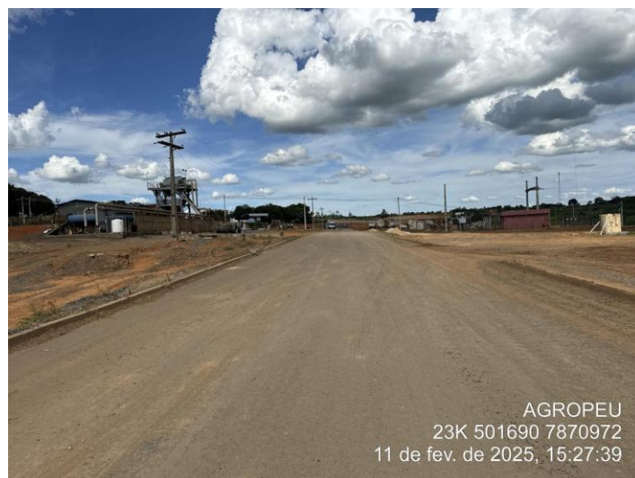
Foto 76: Via do empreendimento que dá acesso até à subestação e os tanques de decantação.
