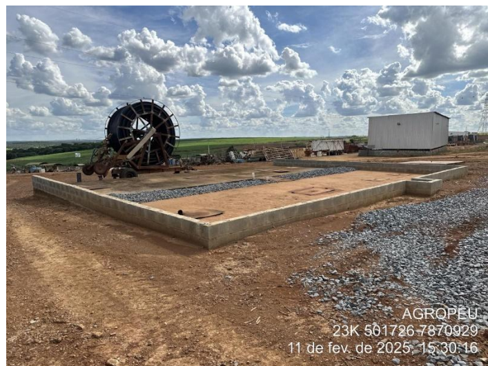
Foto 62: CSAO do empreendimento.
