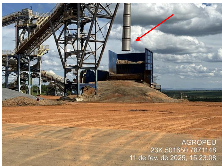
Foto 9: Forma que o bagaço é despejado no pátio.
