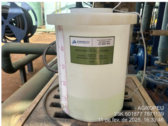
Foto 41: Local onde a água é clorada para ser distribuída para o consumo humano.
