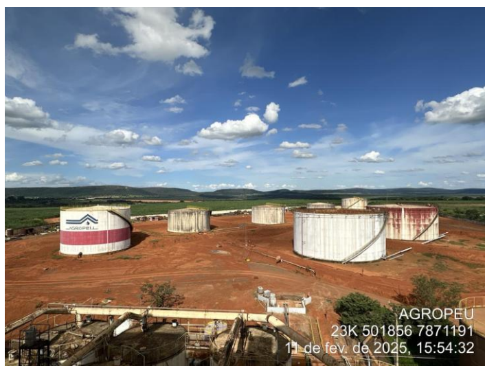
Foto 10: Tanques onde é realizada a etapa de fermentação do etanol.
