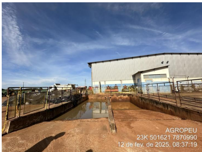
Foto 69: Tanque de decantação dos efluentes advindos do lavador.
