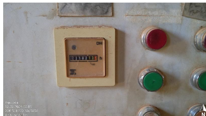
Foto 38: Horímetro associado à captação.
