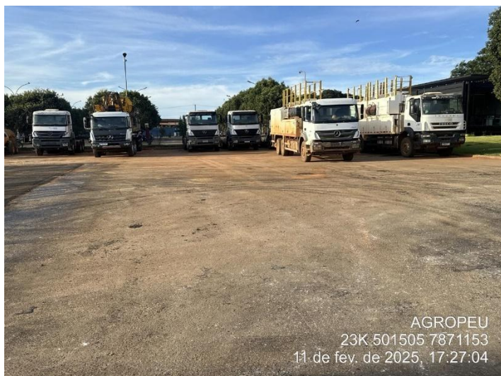
Foto 93: Área destinada para estacionamento de caminhões, próxima a portaria do empreendimento, pavimentada.
