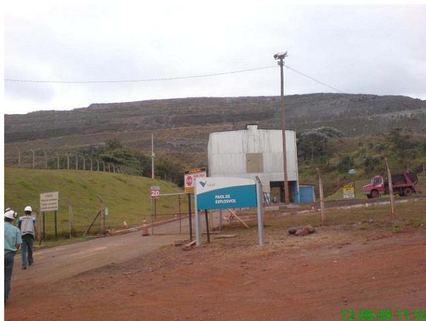
Foto 01. Paio existente na Área Diretamente Afetada .
