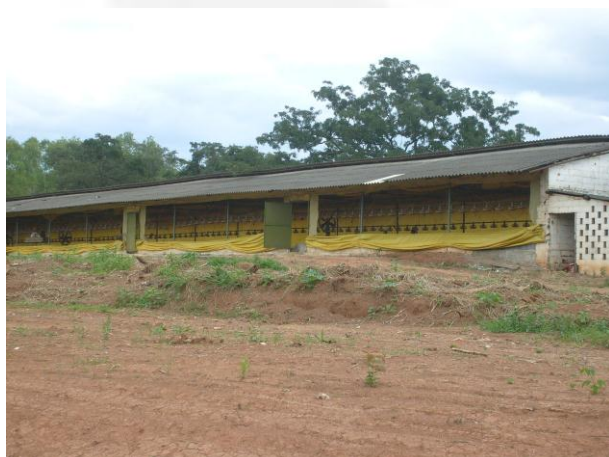
Foto 07. Área Externa do galpão
