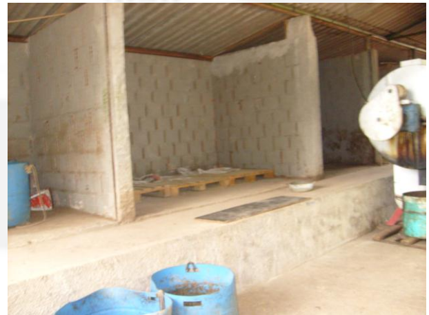
Foto 04. Depósito temporário de Resíduos Sólidos
