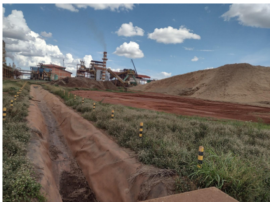
Canaleta de drenagem, armazenagem de bagaço
