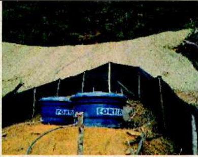
Figura 17. Instalação de novas caixas d'água de recepção e distribuição
