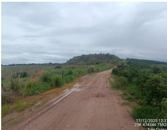
FOTO 7: Pilha de rejeito/estéril
