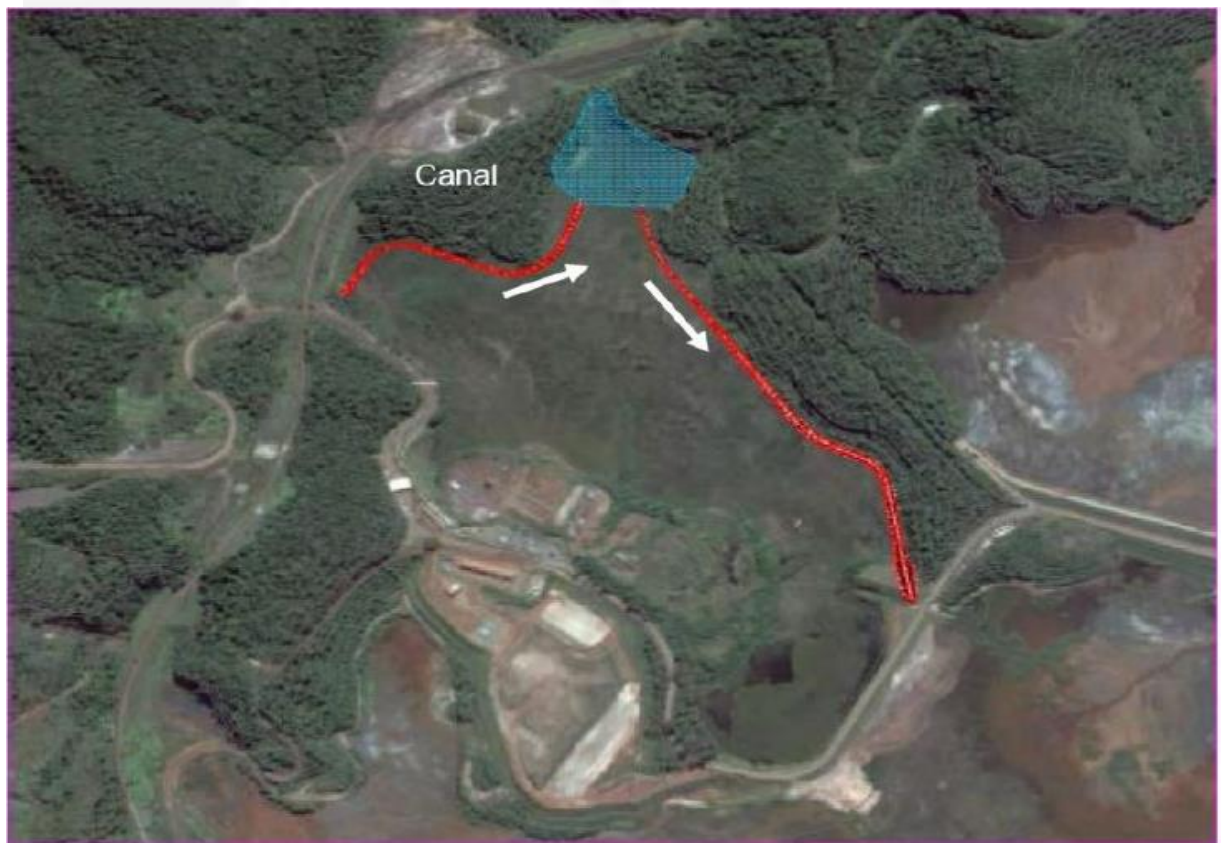
Figura 10 – Canal na Cintura de Drenagem de B5
