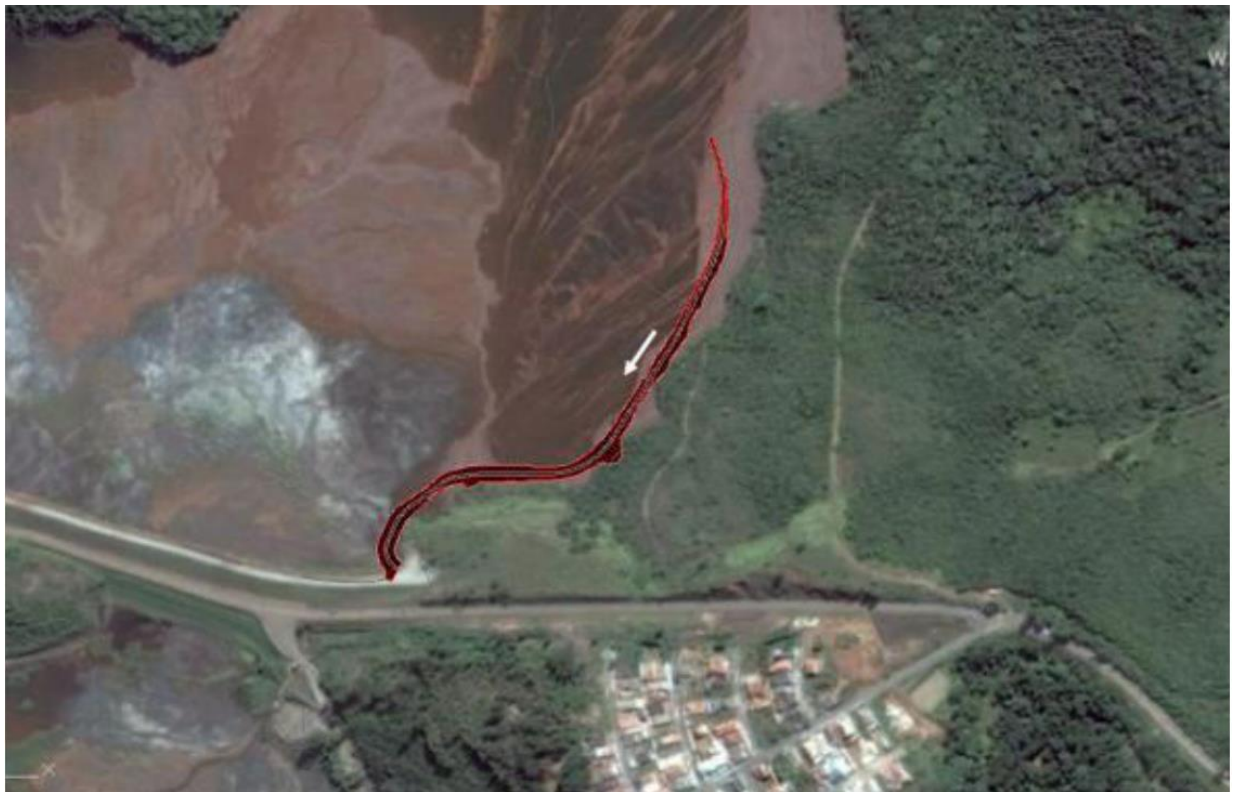
Figura 09 – Canal na Cintura de Drenagem de B4
