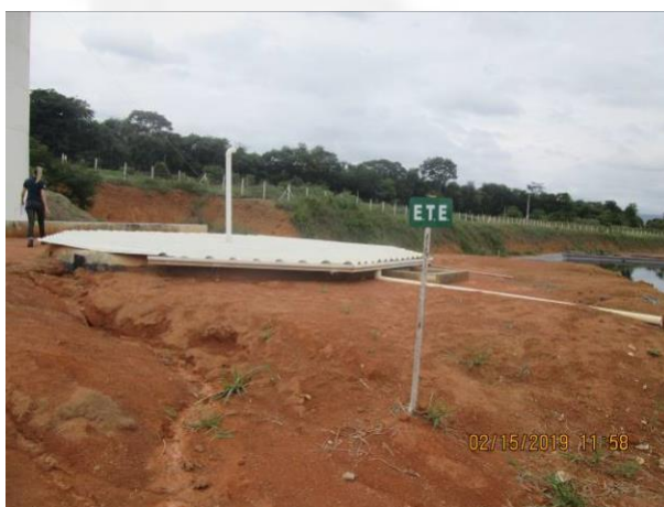
Foto 05. Estação de Tratamento de Efluentes
