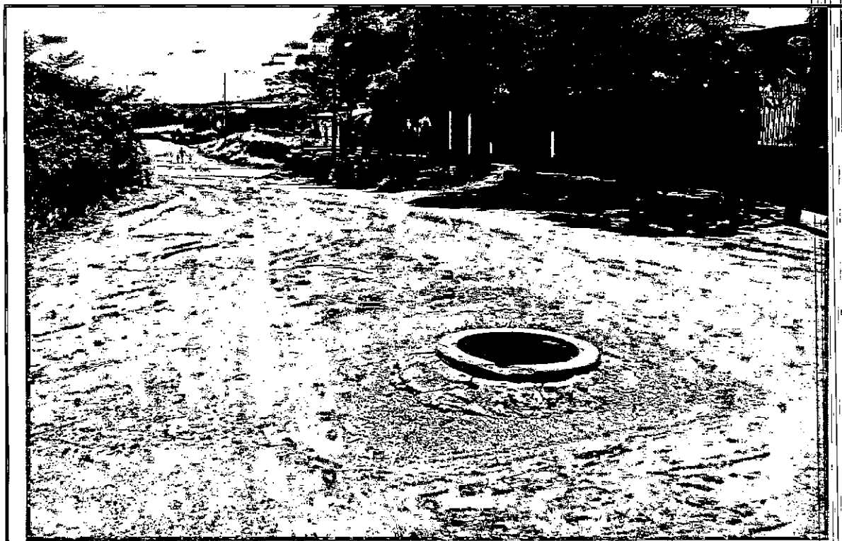
Foto- 26 - Vista de um Posso de Visita sem Tampão no Bairro Jardim Candidés
