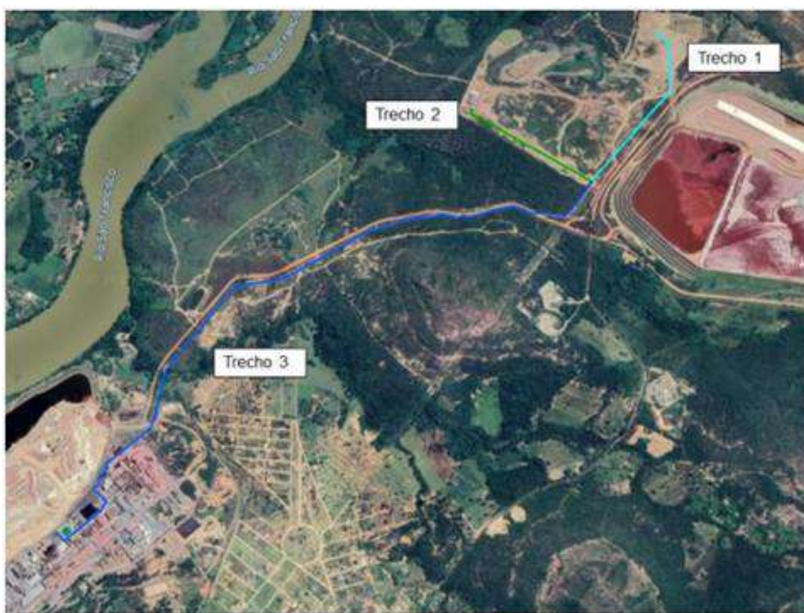
Imagem 11: Linhas de dutos até a ETEi
