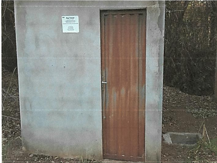
Foto 1- Casa de proteção do poço tubular.
