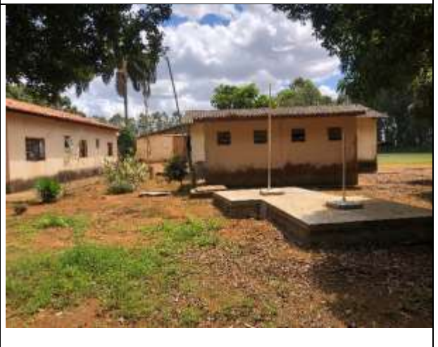
Foto 04. Sistema de fossa séptica biodigestora de uma residência.
