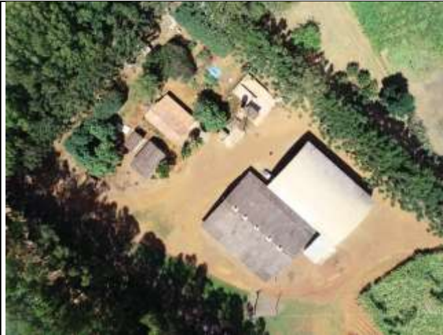
Foto 01. Estruturas de apoio.
