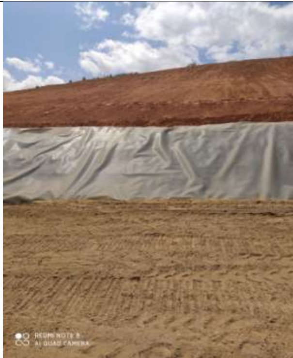
Foto 03: Impermeabilização com manta em 01/09/2020
