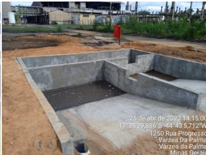
Foto 4: Tanque de tratamento das águas de molhamento do carvão vegetal
