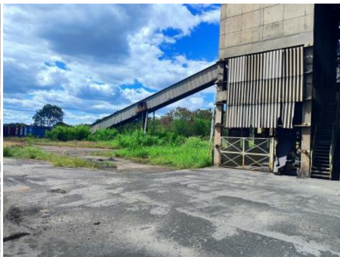
Foto 2: Correia transportadora de carregamento do Forno 36001
