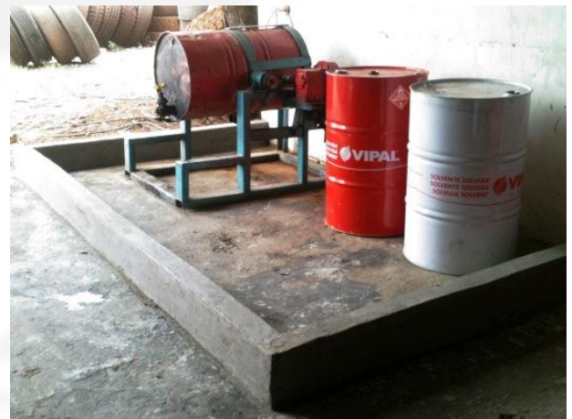
Foto 02. Depósito de cola e solvente
