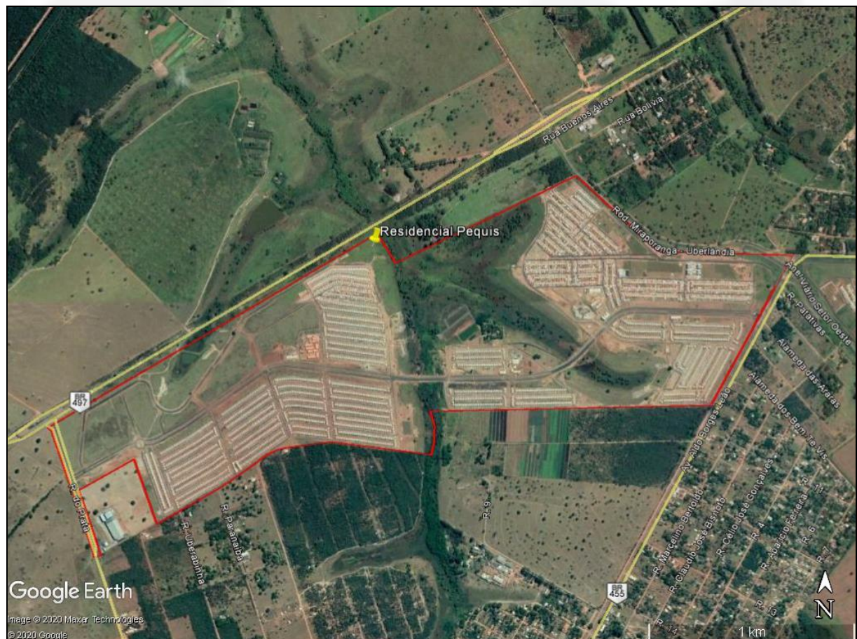
FIGURA 1: Localização e área do empreendimento (imagem do dia 26/05/2018).
