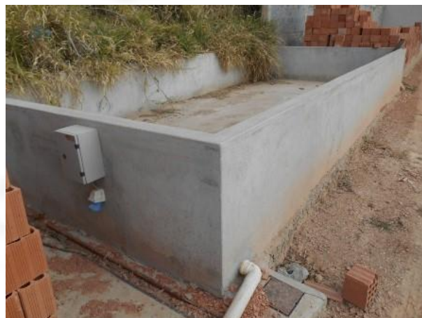
Foto 08. Posto de abastecimento desativado.
