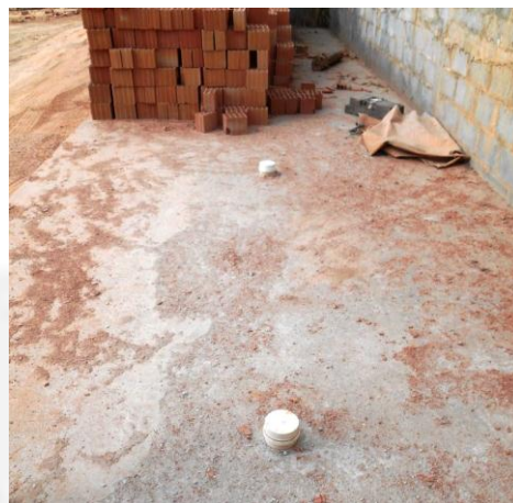
Foto 06. Tratamento de efl. Sanitários.
