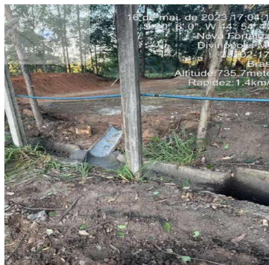
Foto 06: Sistema de drenagem pluvial.
