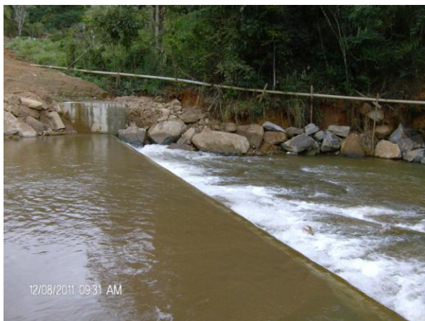
Foto 01. Barragem da CGH no ribeirão Brejaúba.
