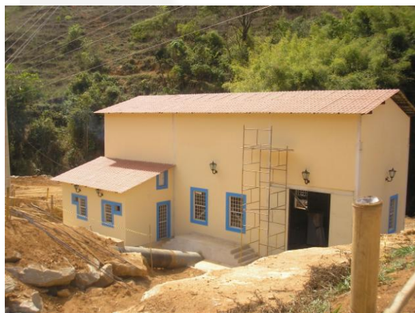
Foto 03. Casa de força da CGH.
