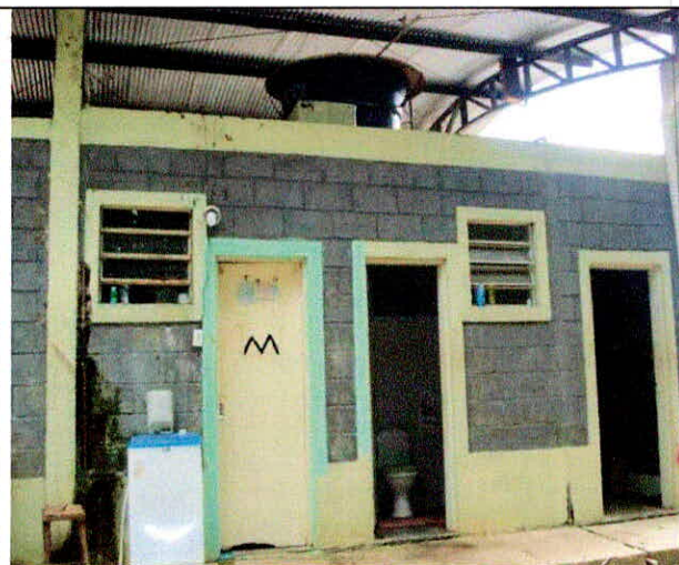
Foto 03: Instalações de apoio.
