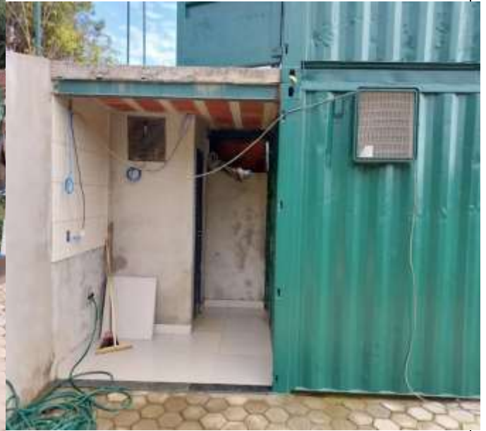
Figura 04: sanitários e escritórios
