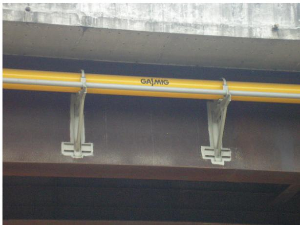
**Foto 01.** Duto acoplado em ponte.
