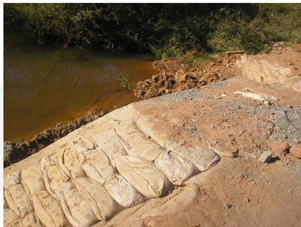
**Foto 02.** Contenção de erosão com sacos de areia.
