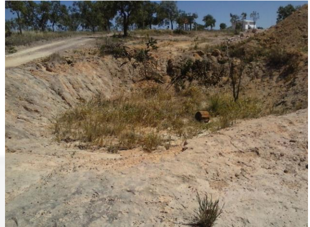
Foto 06. Cacimba para drenagem do terreno.
