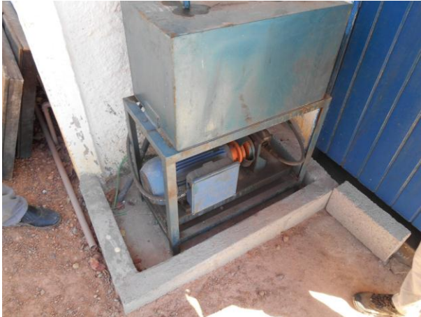
Foto 05. Contenção de vazamentos em compressor.
