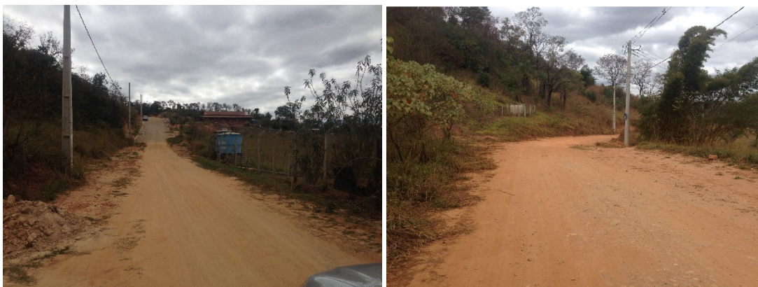
Fotos 01 e 02 – Vias internas, locais onde ocorreram as intervenções.
