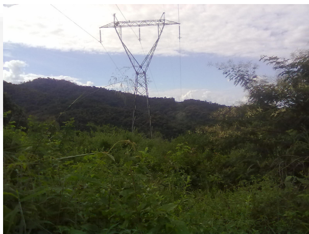
Foto 02. Vista, a partir da Torre18, do local proposto à instalação da Torre19 sentido vante, paralelo à LT existente ao fundo.
